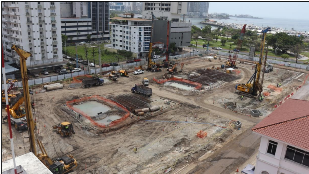
Figura 5. Primera etapa de la construcción del Nuevo Hospital del Niño.
