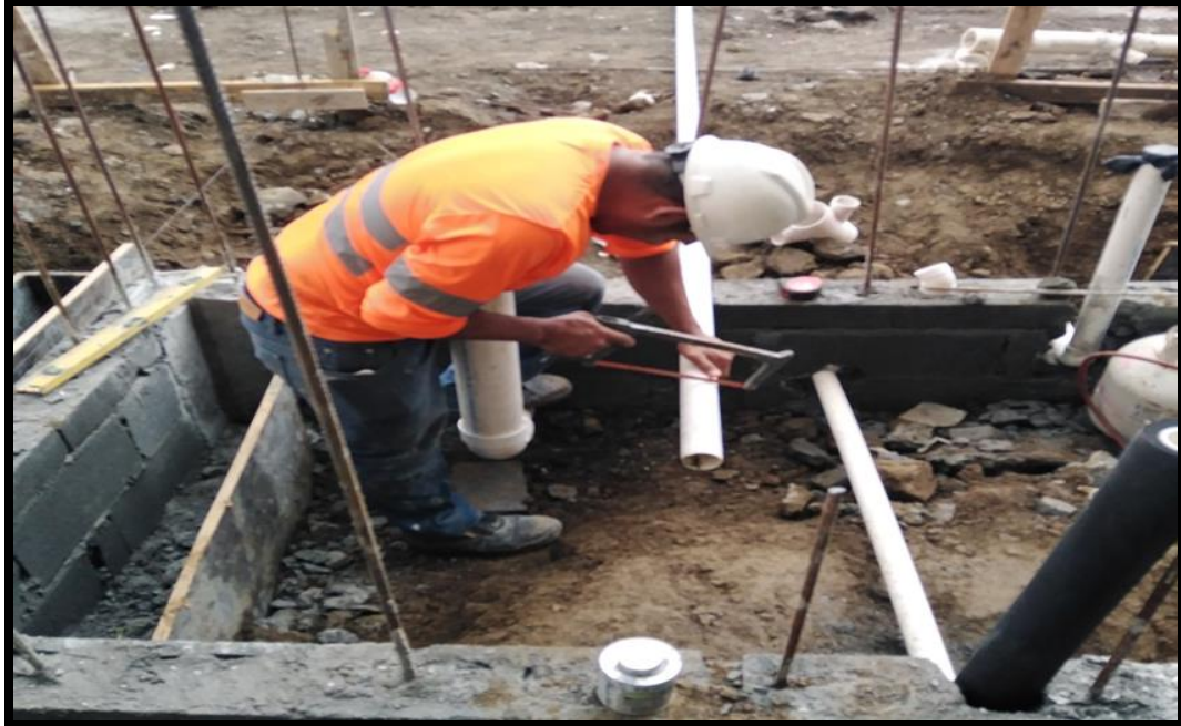
Figura 6: Instalación de plomería
