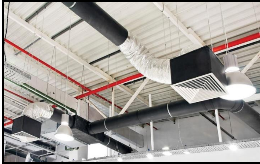
Figura 8: Instalación ductos de aire
