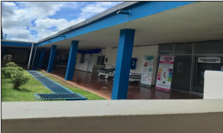
Figura N°5: Visita a sala.
