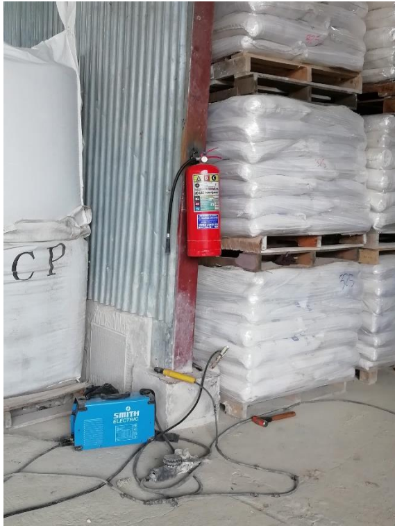
Figura N°31: Supervisión y movilización del extintor mal ubicado.
