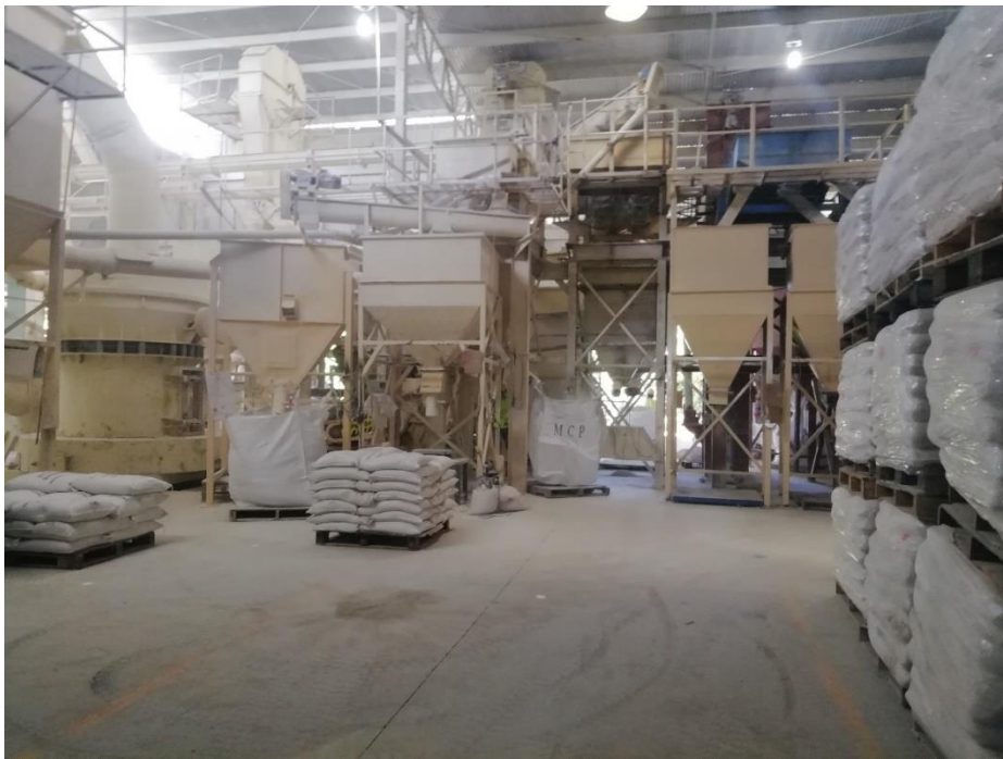
Figura N°28. Maquinarias antes de entrar a laborar
