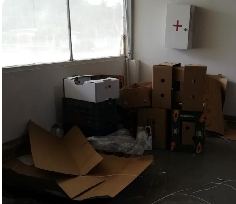
Figura N° 24. Llamado de atención por tener de forma desordenada el área donde se encuentra el botiquín (se recomienda desalojar el área)
