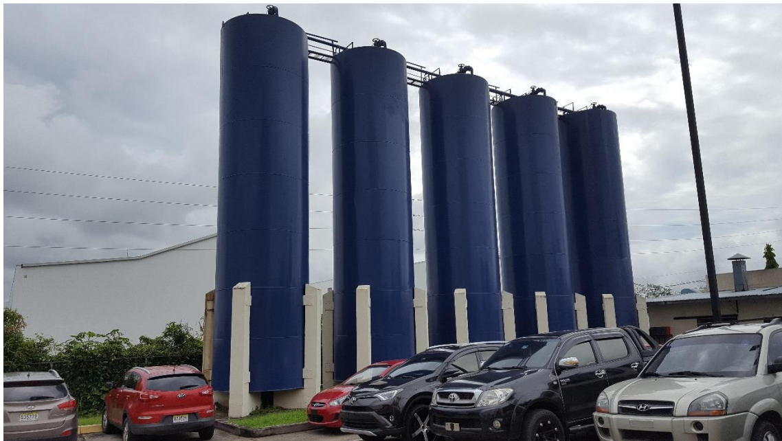
Figura: “23”: Vista lateral del tanque de agua.
