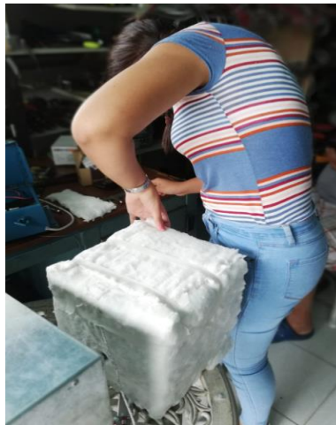
Figura N° 11 Colocación de fibra cerámica
