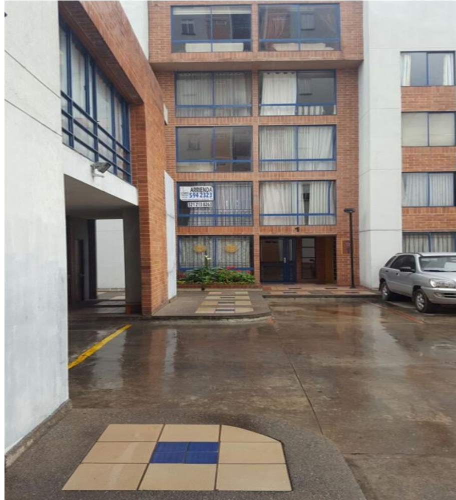
Fotografía 1: Plano General: Se observa la fachada del edificio, hay acceso vehicular y acceso vía peatonal.
